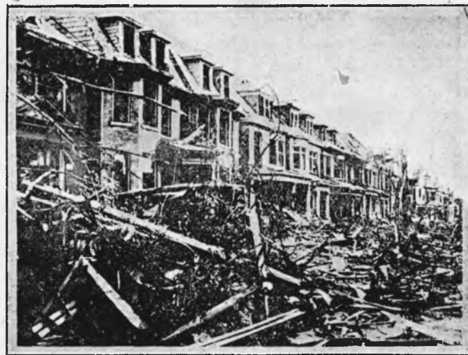
O stradă distrusă de cicloul
