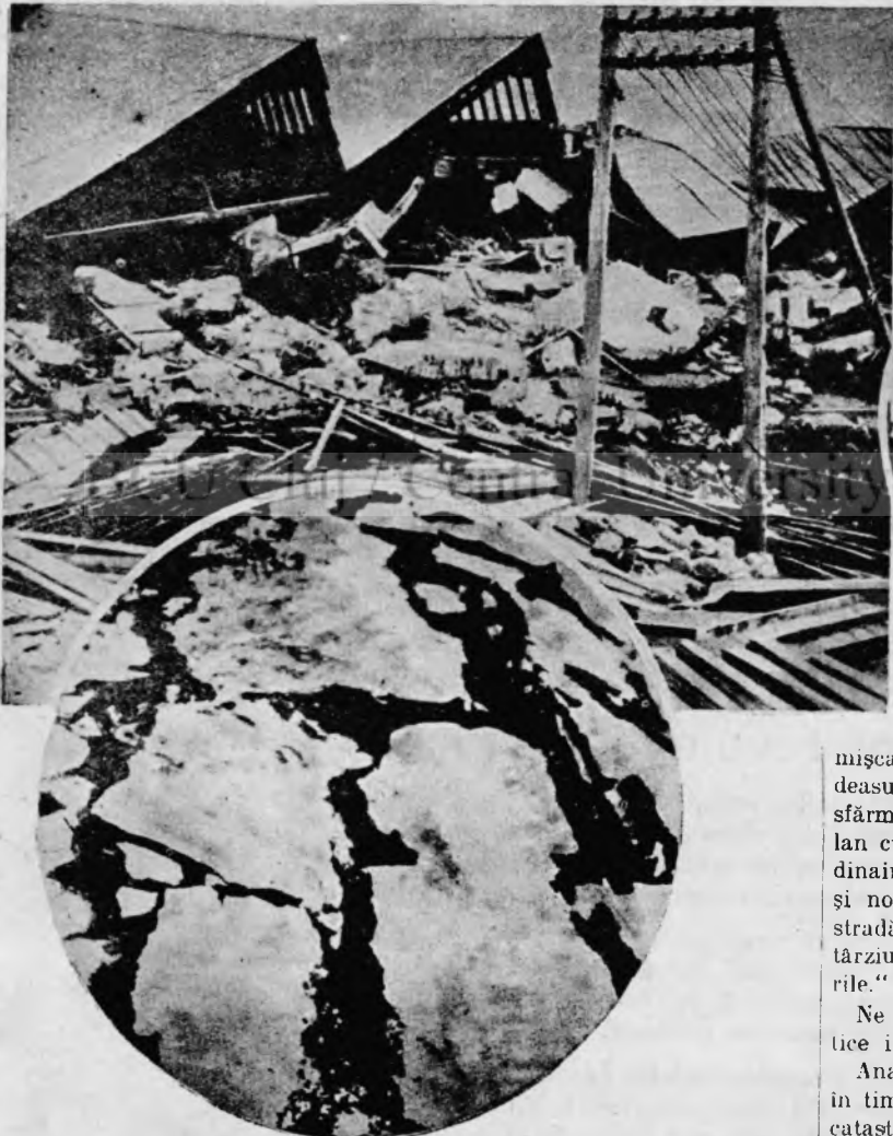
Crăparea străzilor orașului Tokio din cauza cutremurului din 1923.
