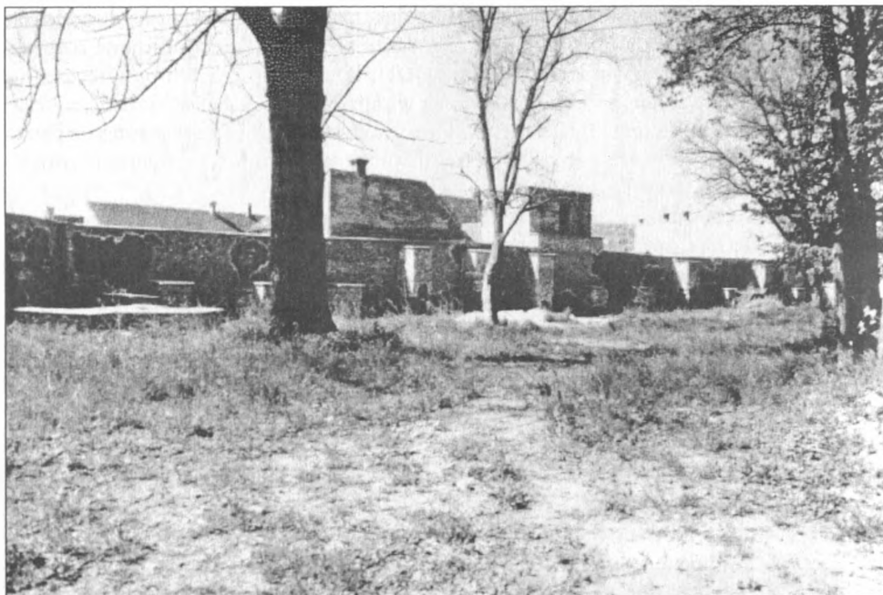
La citadelle d'Orăştie, la muraille intérieure (photo: Pavel Laza)
