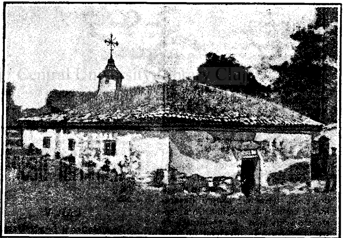
Vederea din afară a bisericii din Căușanii Noi până la reparație
