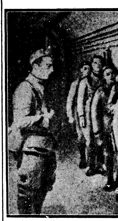
Viața în subteranele liniei Maginot își are confortul ei, care fără îndoială nici nu se poate compara cu viața de tranșee din războiul anterior 1914—1918. Într-o două atacuri soldații își primesc supra
