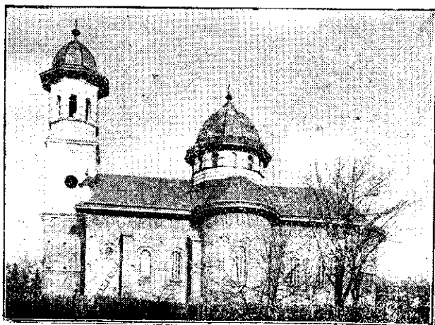
Biserica ortodoxă în construcție.
