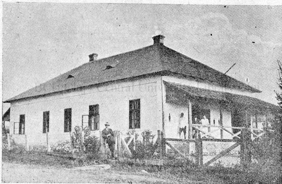
Noile construcții școlare din județul Sălaj. Școala primară de stat din Asuagiul de sus.
