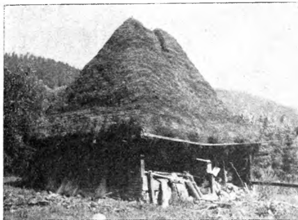
Casă pe valea Drăganului
