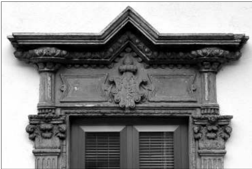
• Ancadrament de fereastră renesanțist clujean, al imobilului din Piața Unirii, nr. 31, construit în a doua parte a secolului al XVI-lea, la comanda proprietarului, Ștefan Kakas. Foto: Lukács József
