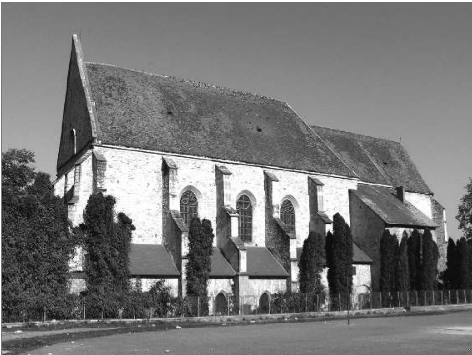
• Biserica reformată din Cluj, str. Mihail Kogălniceanu. Vedere dinspre sud. Foto: Várdai Levente
