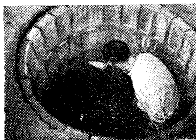
A téglafal alatt kezdődő vakolattal második 1 cm-es rétegének elkészítése az első réteg kellő megszikkadása után, ugyan-csak 1:7 keverési arányú kavicsos cementhabarcsból, mészt hozzáadása nélkül.
