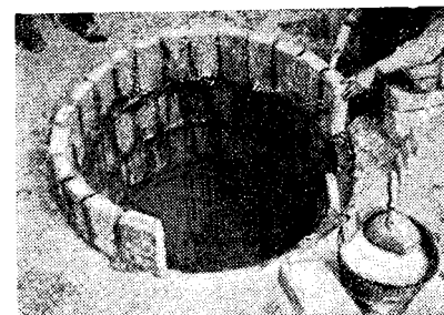
A földfeletti éltéglafal elkészítése 1:3 keverési arányú cementhabarcsba ágyazva.
