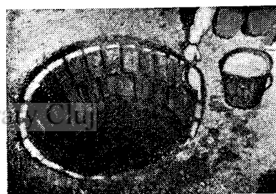
A földalatti éltéglafal és a földfal közötti hézagnak kitöltése 1:7 keverési arányú cementhabarccsal. Majd a siló végleges mélységének kiásása.
