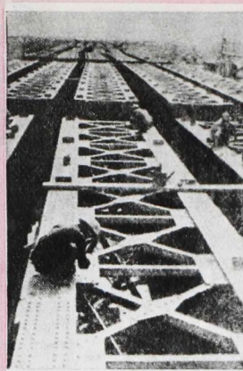
Kína leghosszabb (3 kilométeres) vasúti hídjához készülnek ezek a gigantikus acéltraverzek
